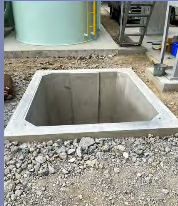
角型マンホール
