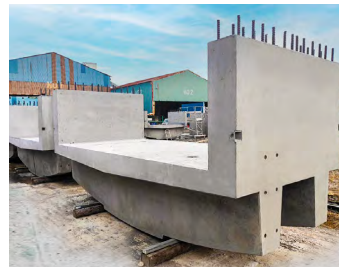
セグメント用内部構築
